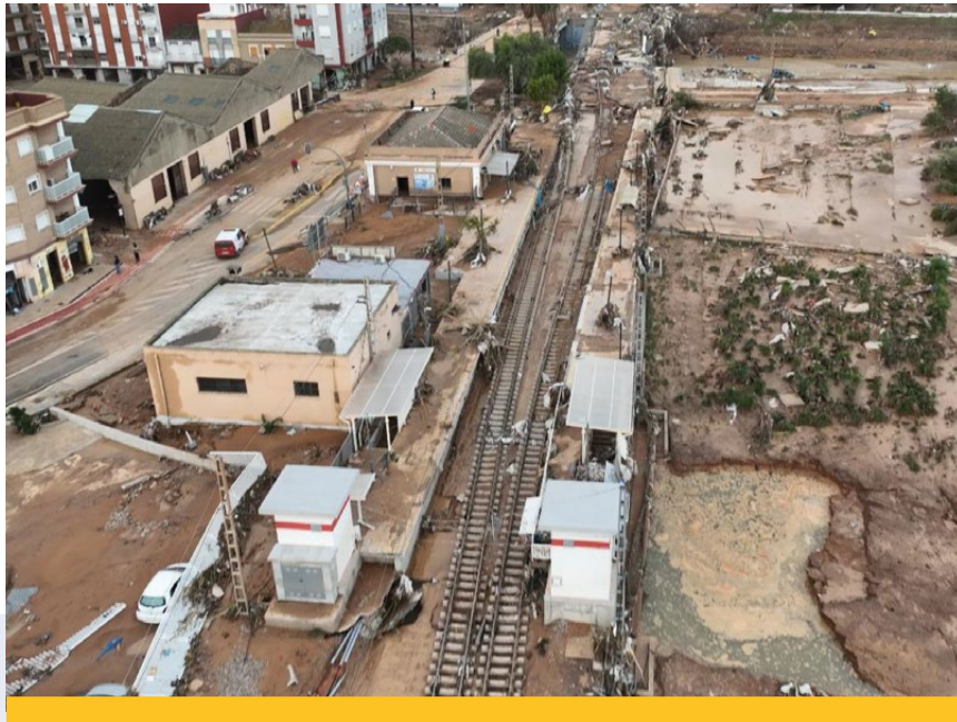
Infraestructura ferroviaria: Se registraron daños importantes en las líneas 1, 2 y 7, especialmente en los tramos colindantes a Paiporta y Picanya. Las afectaciones incluyen la superestructura de vía, puentess, sistemas de comunicación, señalización, línea aérea, entre otros elementos clave.
