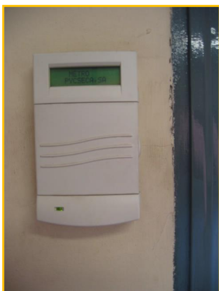
Detalles del terminal de alarma antirrobo de las estaciones de superficie
