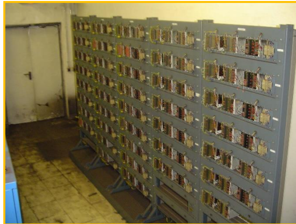
Electrónica del enclavamiento de Almàssera montada en bastidor
