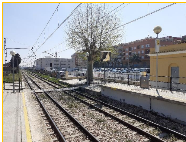
Vía convencional con traviesa de hormigón y balasto
