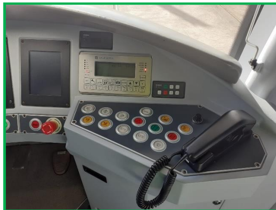
Imagen 10: Terminal de fonía en una cabina de conducción de un UT 4200
