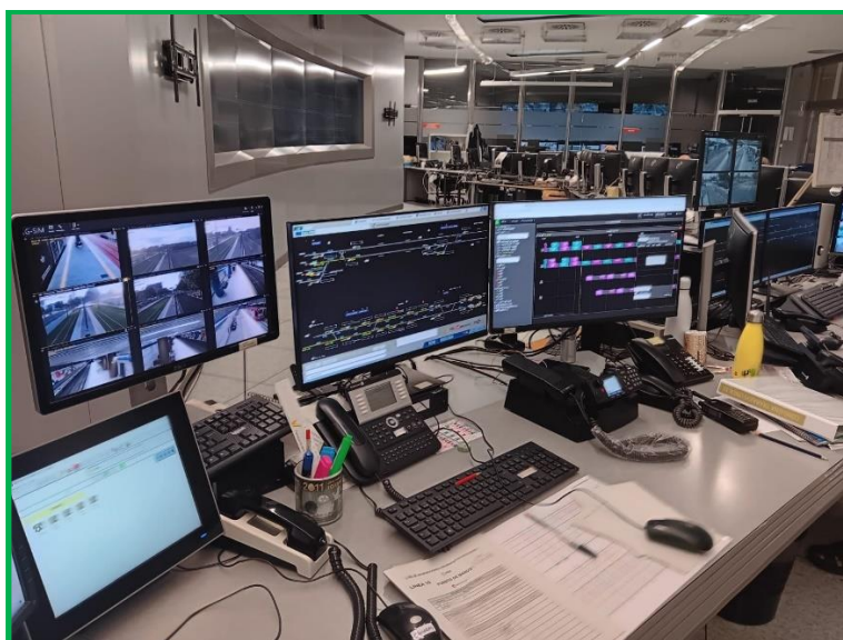
Imagen 13: Puesto de regulación con CTC y SAE- línea 10 de València
