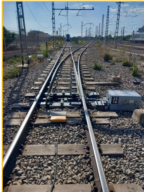
Desvío tipo ferroviario de Talleres Machado València
