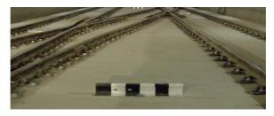
Se encuentra situado en el ángulo de convergencia de dos vías e indica el punto hasta el que es compatible la circulación por ambas vías.
