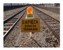
Solo la vía afectada por los trabajos, cuando los trabajos se realicen en instalaciones con andén central o cuando exista una barrera física entre la zona de trabajos y la otra vía.
