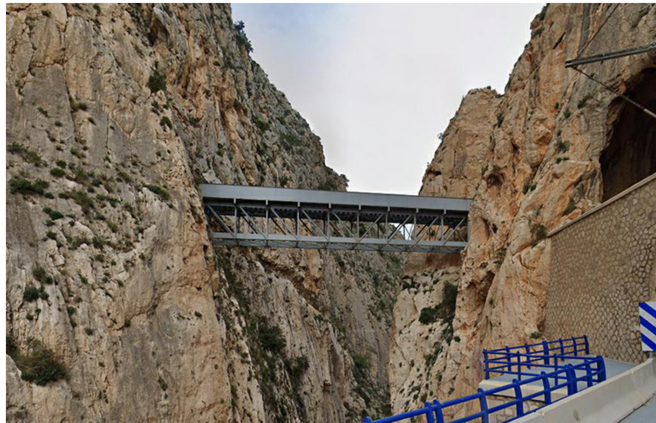
VISTA GENERAL. VIADUCTO MASCARAT
