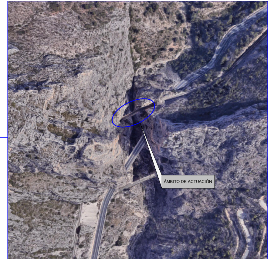
IMAGEN AÉREA VIADUCTO MASCARAT
