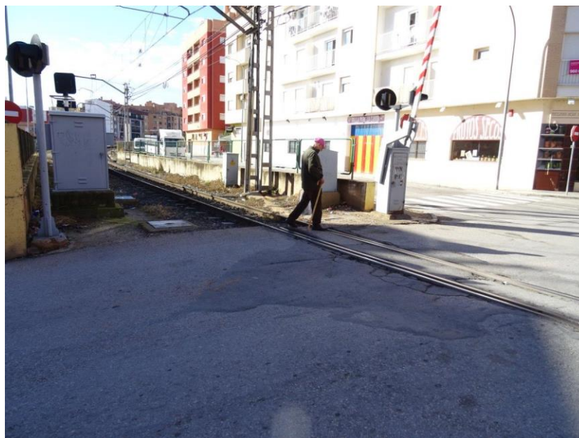
Vistes des del pas a nivell de vianants PC-7
