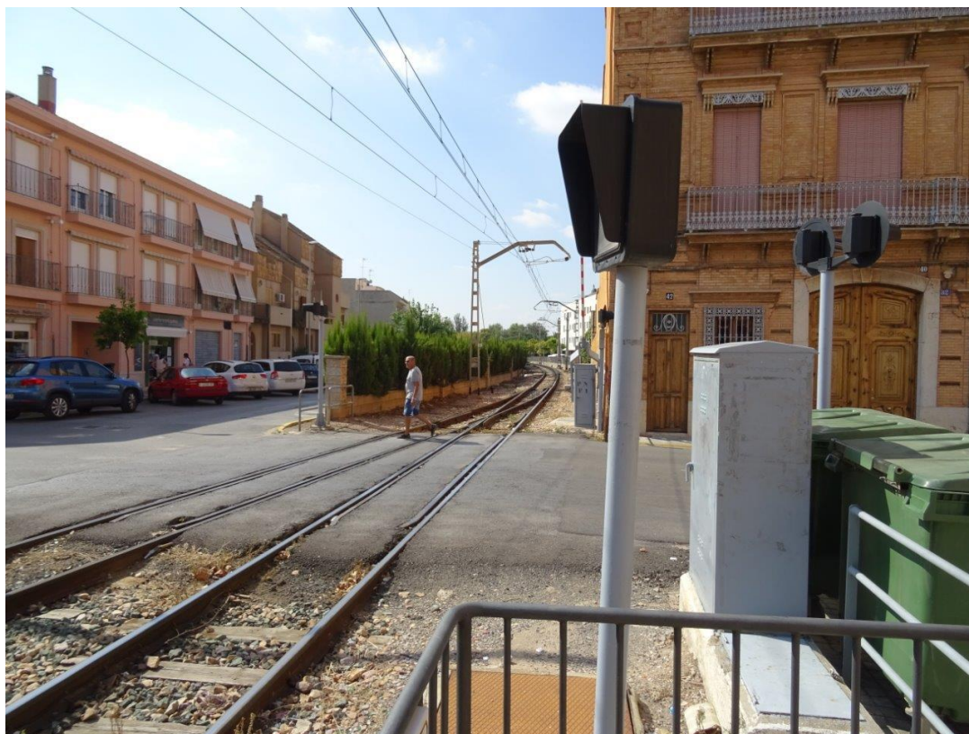
Vista des del pas a nivell per a vianants F-1
