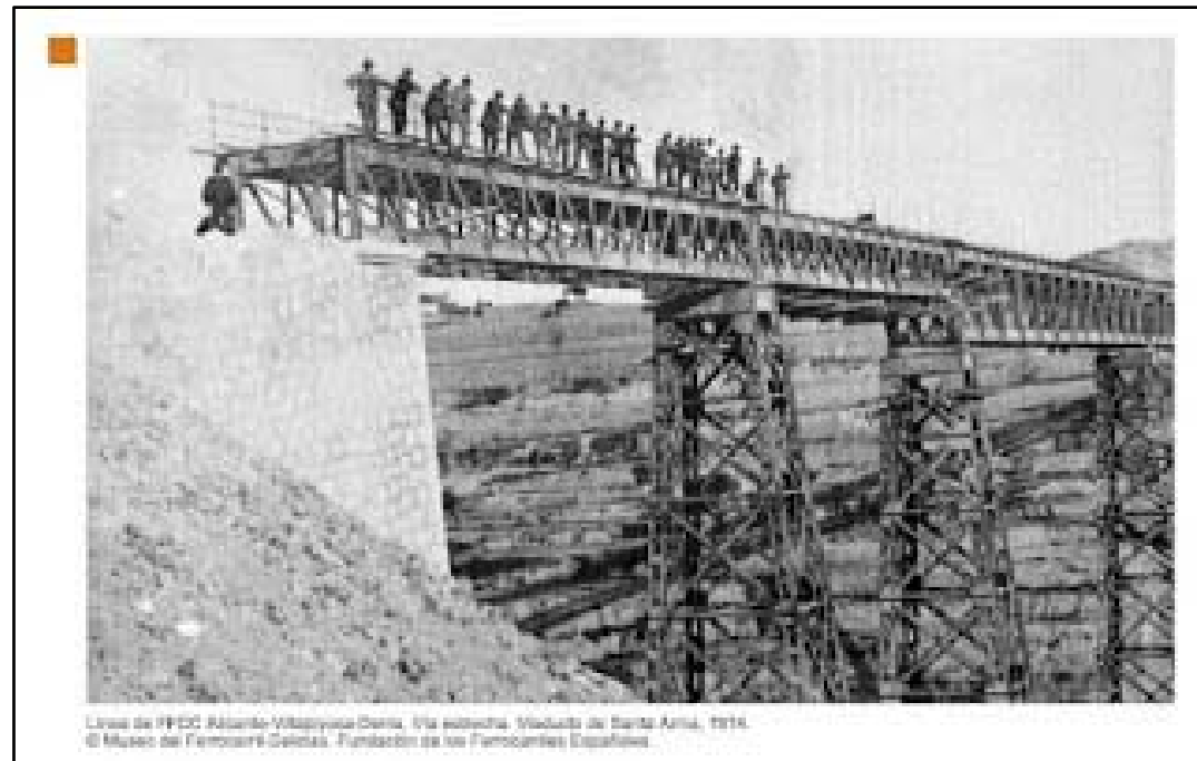
Figura 6. Construcción Viaducto Santa Ana
