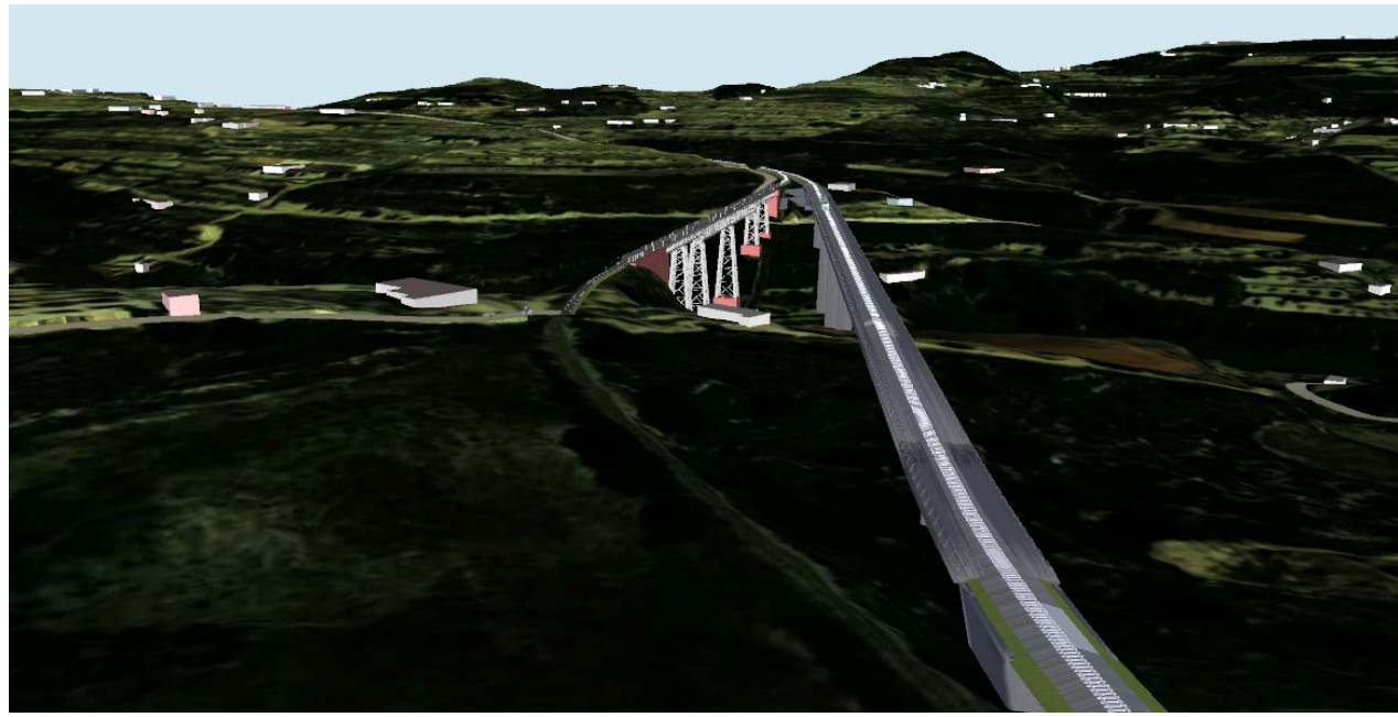
VISTA DESDE ESTRIBO E1
