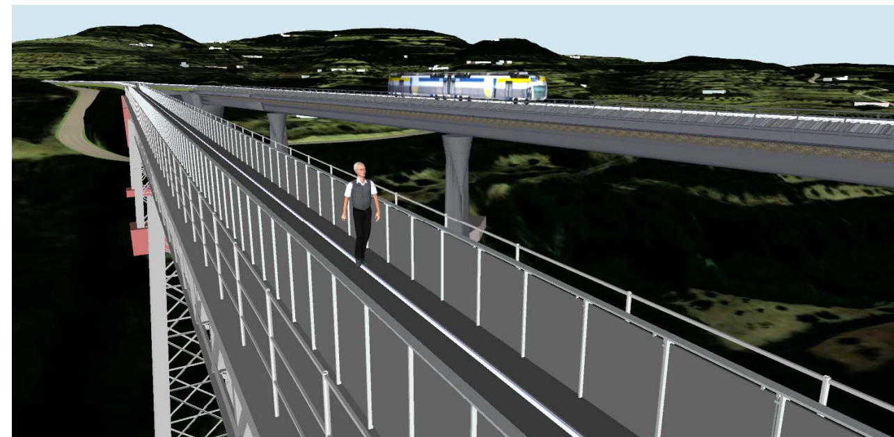
Infografía 2. Vista General Viaducto de Santa Ana.
