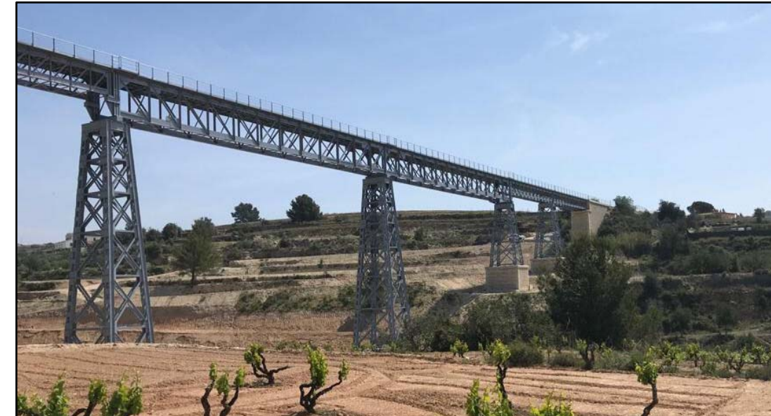
Figura 7. Viaducto Santa Ana Rehabilitado.
